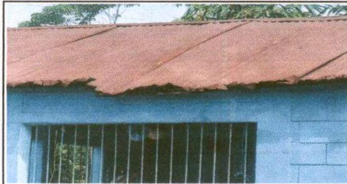
Foto 1 Sustitución de cubierta de lámina por lámina troquelada aluzinc.
